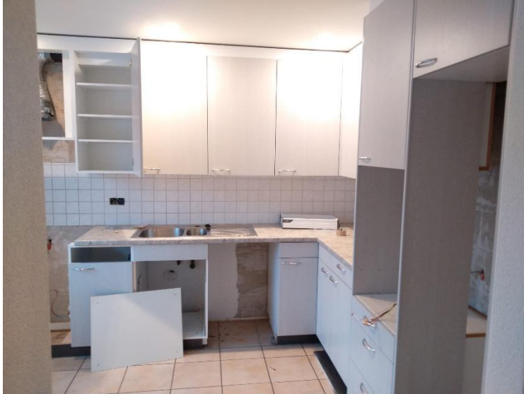
Abbildung 4 Demontage alte Küchen
