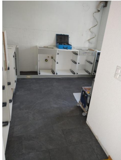
Abbildung 5 Einbau Korpen
