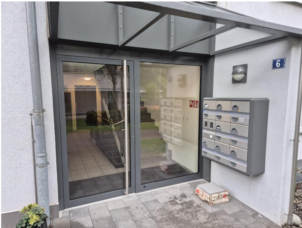
Abbildung 4 Eingangsbereich mit Aluminiumtüren
