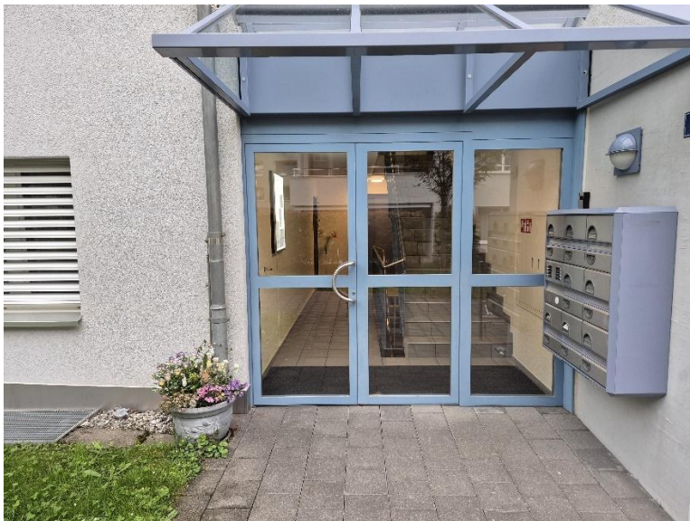
Abbildung 10 Türen mit unterschiedlichem Anstrich
