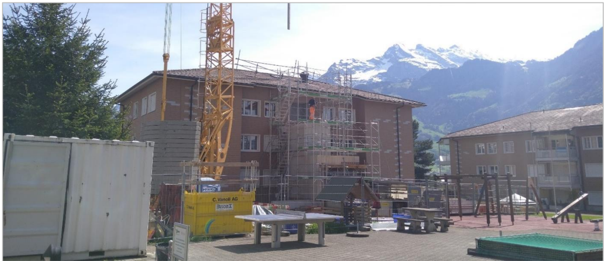
Abbildung 8 Liftturm bei Haus 29
