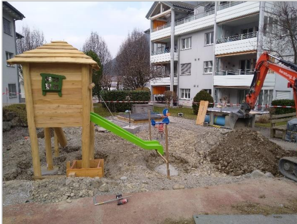
Abbildung 5 Bauarbeiten neuer Spielplatz
