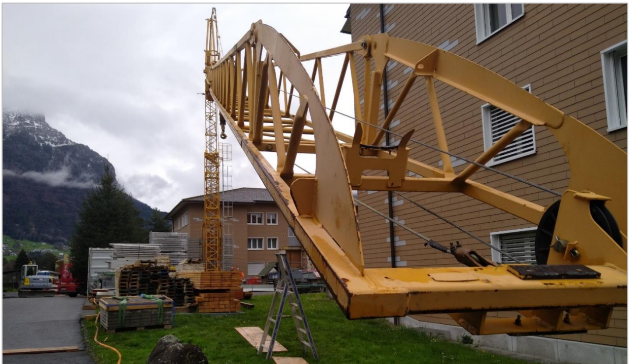
Abbildung 11 Verlängerung des Kranauslegers
