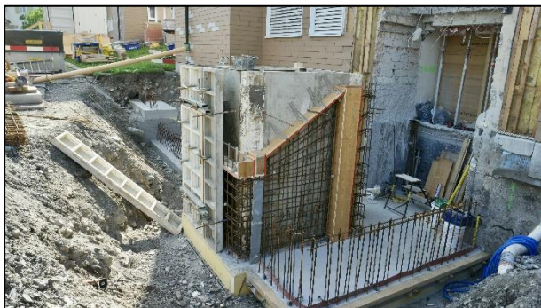
Abbildung 13 Liftschacht im UG
