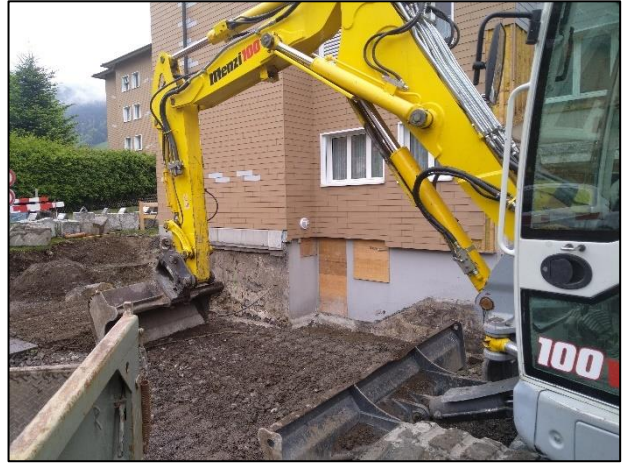
Abbildung 12 Aushub für den Fahrradkeller
