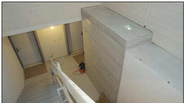
Abbildung 10 Estrichtreppe mit Liftschacht
