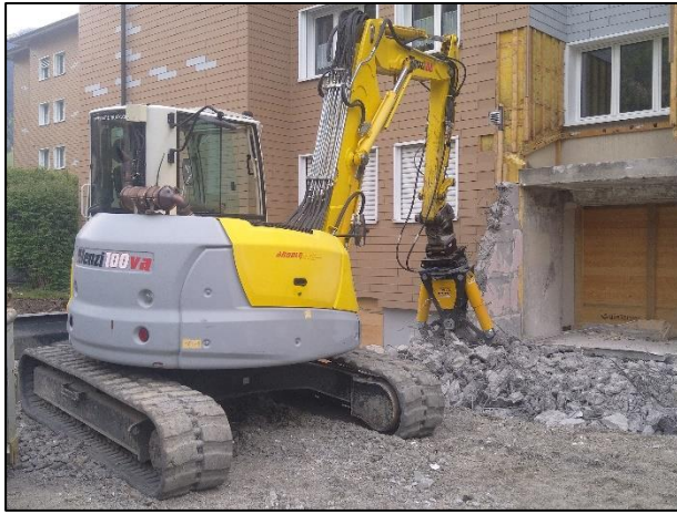
Abbildung 11 "Betonbeisser" in Aktion
